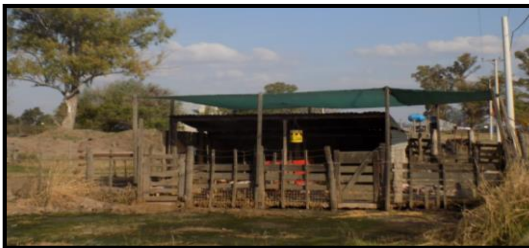
Imagen N° 24: frente de la pista de frente abierto para la cría.
