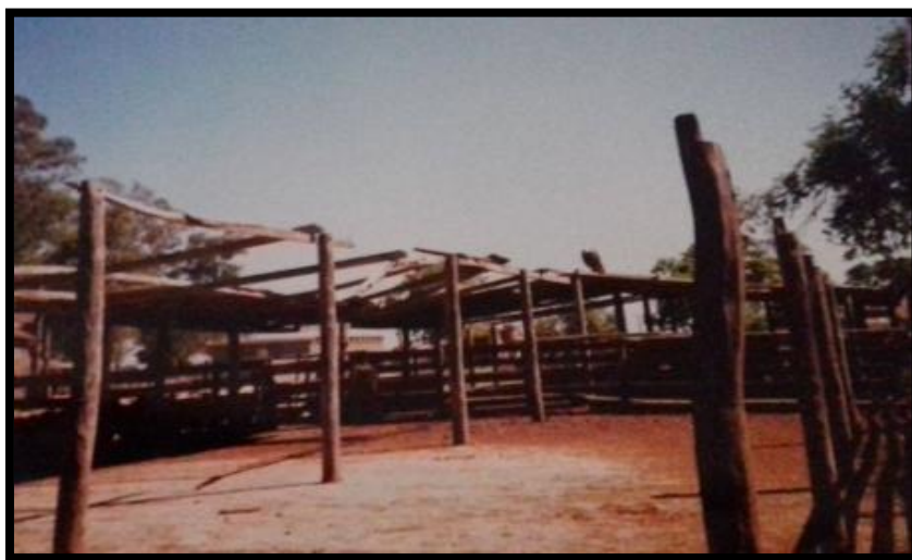
Imagen N° 18: galpón de gestación al inicio.
