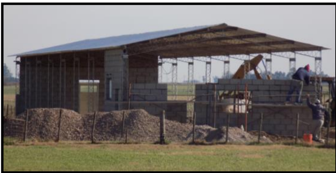
Imagen N° 29: galpón de gestación en construcción.
