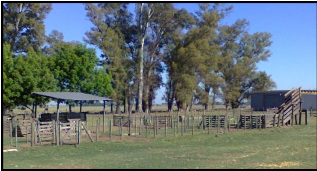
Imagen N° 28: instalación de manejo.
